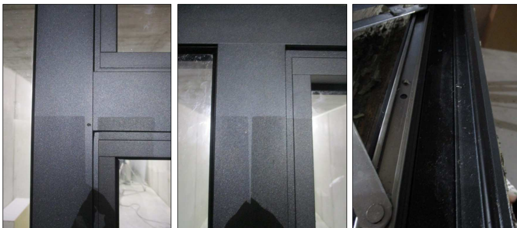
Imágenes 13 a 15 Detalles de la ventana ensayada (Perfiles y juntas)
