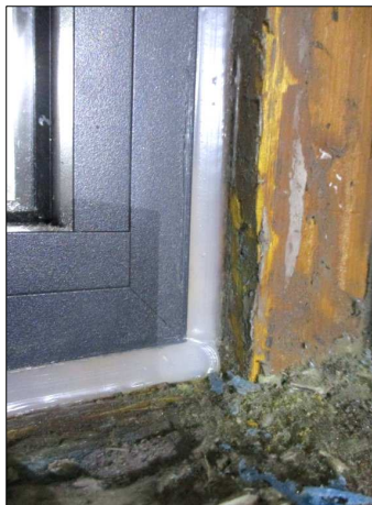
Imagen 4 Sellado de holgura ventana – abertura de ensayo
